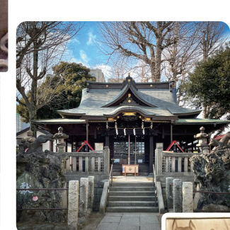
⑬ 橋戸稲荷神社 区内唯一の土蔵づくり本殿。鏝絵は2月、5月、9月のご開帳時に見られる。
